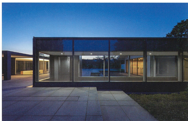
新設したエレベーター(連絡通路)
